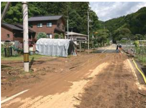
土砂災害および浸水の被害状況を確認
