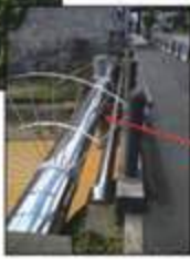
京口橋への水位計取り付け
